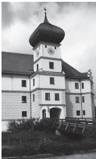
Die Seminarräume befinden sich in einem Wasserschloss.
